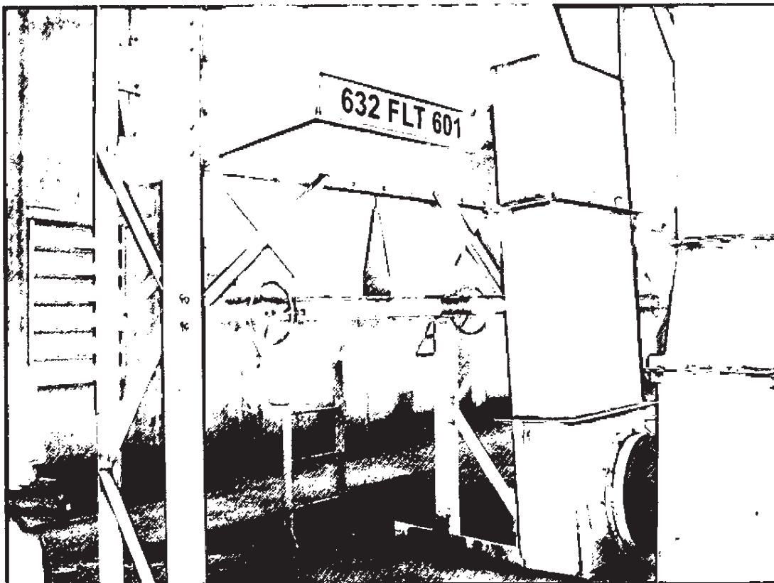
Figura 4.4 – Filtro de carvão ativado utilizado para tratar as emissões das fábricas.
