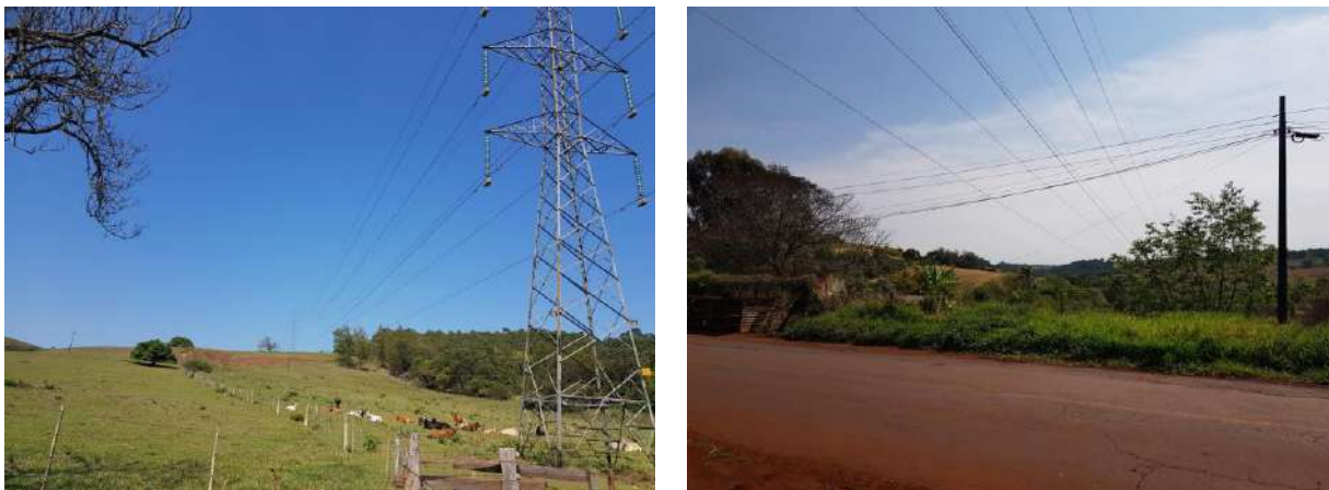
Figura 31 – Linha de transmissão de energia na AEU-DS
