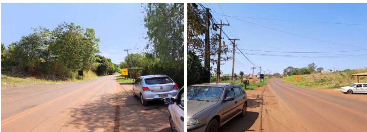
Figura 36 - Rodovia João Alves da Rocha Loures
